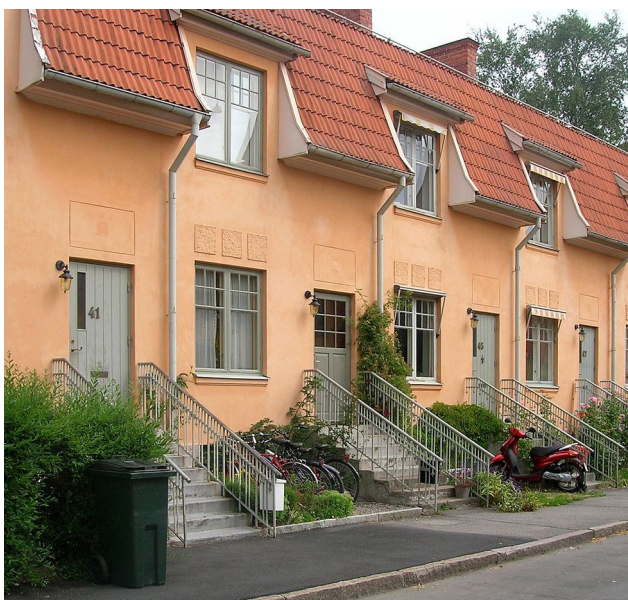
Bild 1. Stadsradhus på Margaretavägen i Enskede. Husen uppfördes 1908 och är de första av sitt slag i Sverige. Stora delar av Enskede byggdes av de boende själva i så kallade egnahemsprojekt. Bildkälla: Riksantikvarieämbetet
